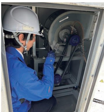
Vベルト張力測定
