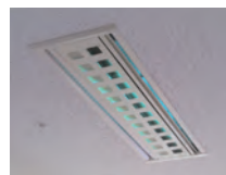
搭载UVC灯的风机盘管机组 (已取得专利)
