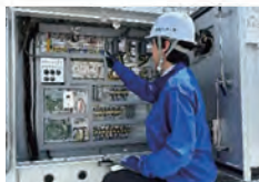
空调箱控制面板检查
