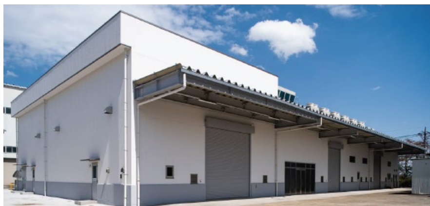
<神奈川工場にある空調機総合実験棟の外観>
