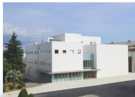
SINKOテクニカルセンター概観
