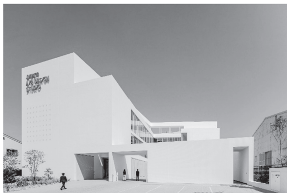
写真-1 建物外観
