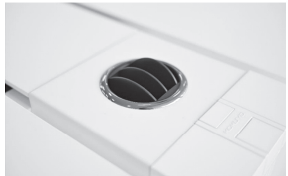
写真-5 デスク上に設置したパーソナル吹出口
