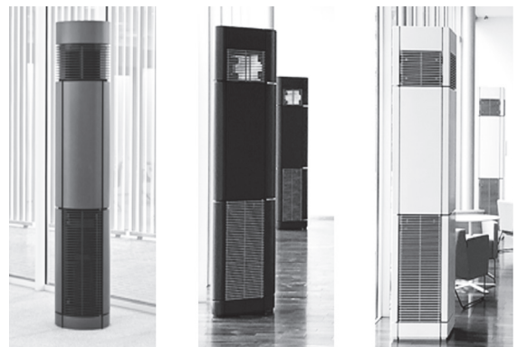
写真-6 各階形状の異なるポスト型ファンコイルユニット
